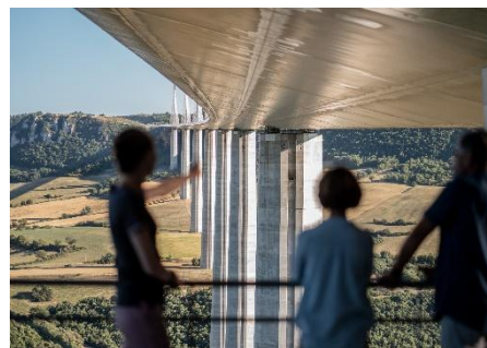
Le viaduc © CEVM Eiffage Foster&Partners Greg Alric_juillet 2022
